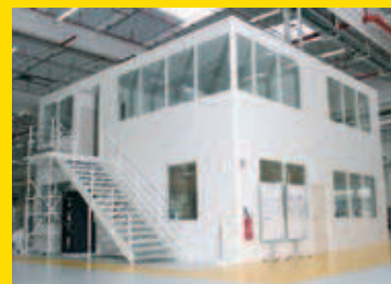
Bureaux sur 2 niveaux.
