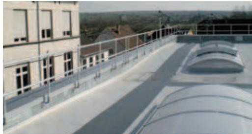
Garde-corps aluminium fixé sous couvertine.
