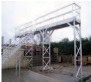
Passerelle pour nettoyage des bennes
