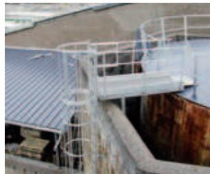
Echelle à crinoline + passerelle d'accès sur cuve.
