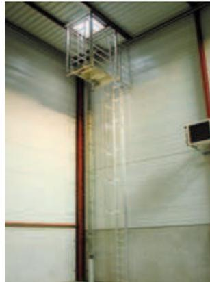
Echelle à crinoline avec palier d'arrivée suspendu.
