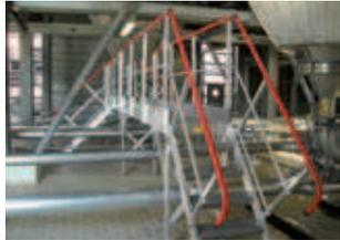
Passerelle de franchissement d'une chaîne de fabrication convoyage - Brasseries
