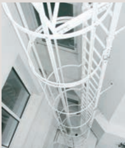
Crinoline laquée blanche en station d'épuration
