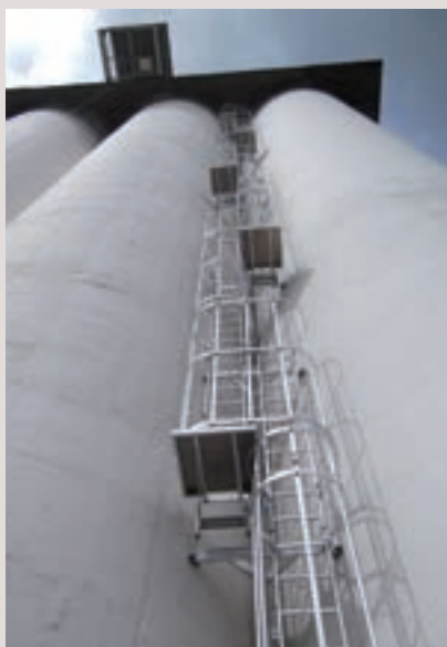
Crinoline de 30 m sur silo de stockage
