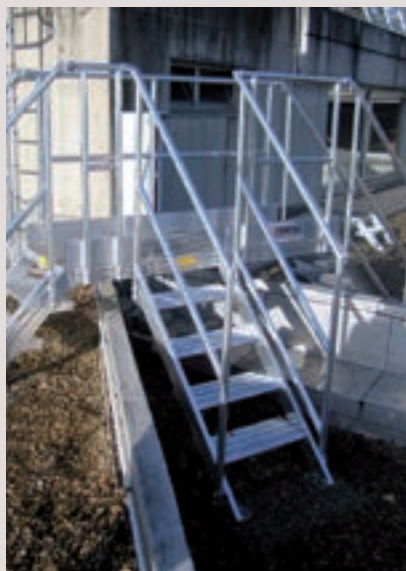
Escalier pour passage de tuyauterie sur toiture-terrasse
