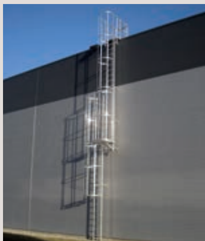
Crinoline sur bâtiment industriel
