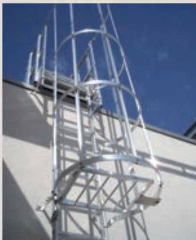
Accès en toiture et condamnation basse
