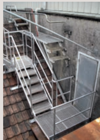
Passerelle et escalier de cheminement sur toiture
