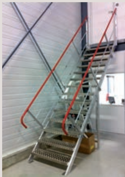
Escalier droit avec main courante laquée rouge
