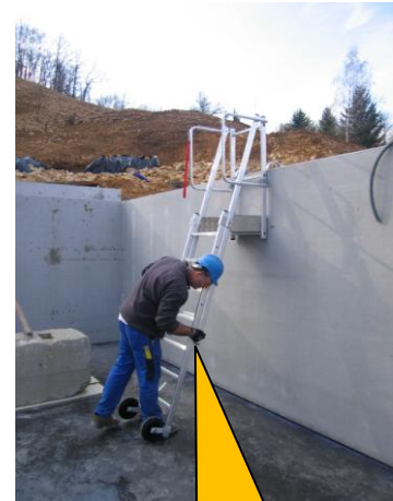
Régler la hauteur par déverrouillage de la partie basse
